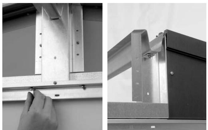
**7.** Geben Sie jeweils ein Dachauflage-Profil **G** wie dargestellt auf das Kopfprofil **B** der linken und rechten Seitenwand und verschrauben Sie es mittig mit dem Kopfprofil. Jetzt erst verbinden Sie in der Ecke die beiden Kopfprofile **B**, das Giebelblech **N** und die Dachauflage **G** mit einer Schraubverbindung. Falls Sie die Löcher nicht gleich in Deckung bringen können, verwenden Sie bitte den beiliegenden Nagel.
