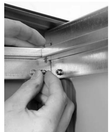
**8.** Legen Sie je eine Dachrinne **K** auf die Dachauflage **G** der Seitenwände und sichern sie die Dachrinnen durch Knicken (siehe Perforation) der äußeren Enden des Giebelbleches **N**.
