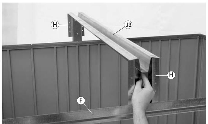
**Achtung:** Bitte beachten Sie den richtigen Zusammenbau der Firstträger **J2** und **J3**: Zuerst Firstträger **J3** auf die Firststützen **H** legen.
