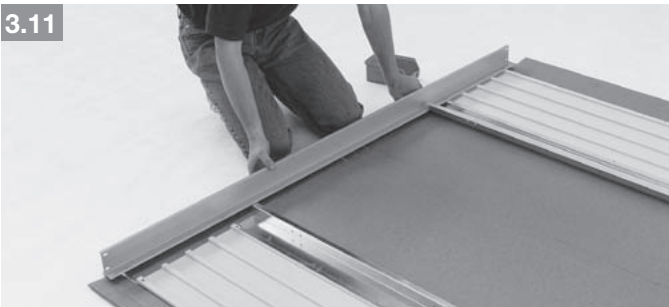
Kopfprofil einschieben & verschrauben | slide & fasten the top frame profile
